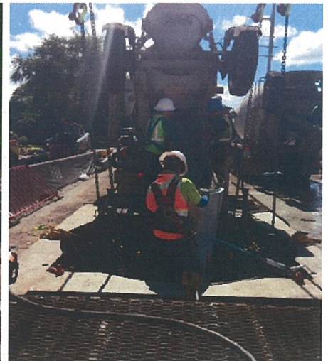
Concrete Foundation Pour
